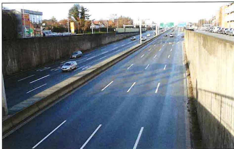
Helsingørmotorvejen set fra Emdrupvejbroen med kig mod nord. Billedet til venstre er samme kig efter etablering af en overdækning.
